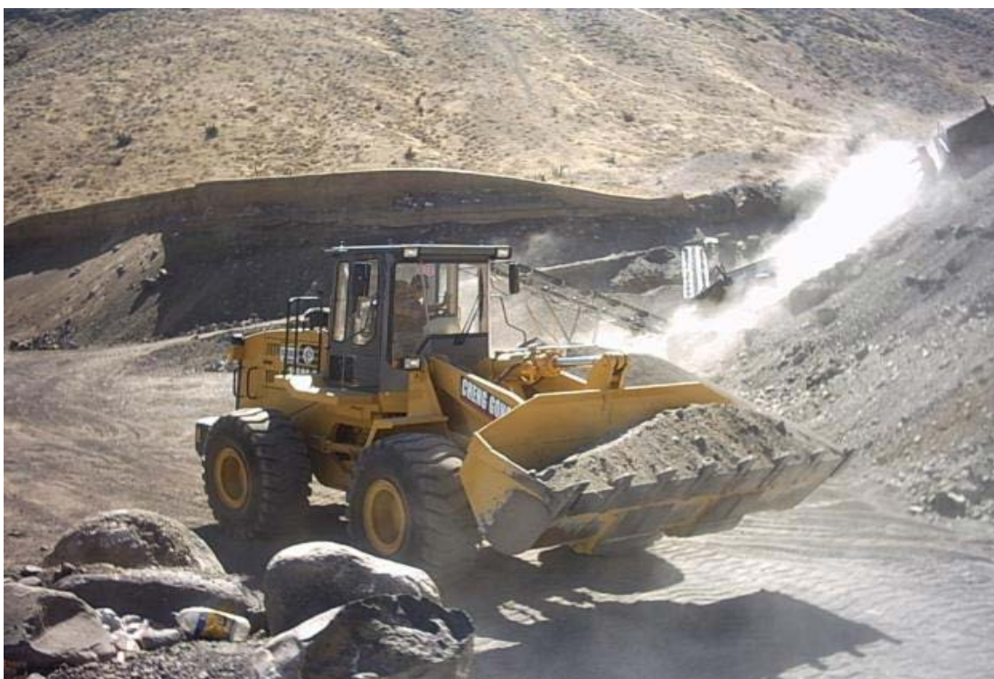
Figura N° 25 Cargador Frontal transportando Material Suelto
