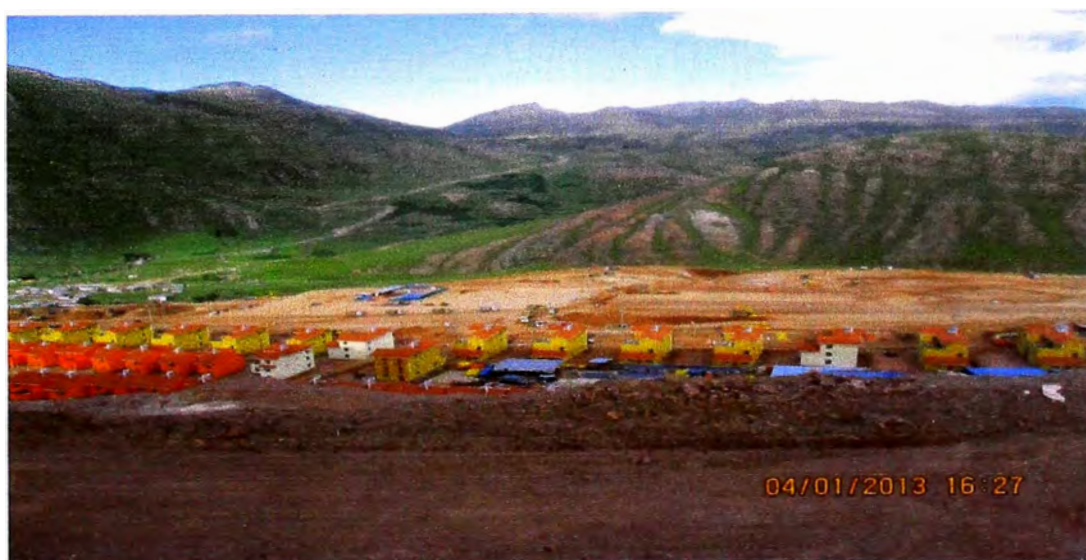
Figura 4.2 – Avance del proyecto Nueva Fuerabambas
