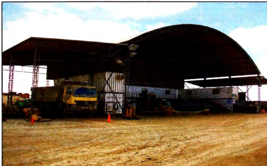
Figura 3.2 – Taller de mantenimiento fijo del proyecto Consorcio Marcona
