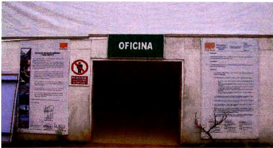
Figura 3.7 – Oficinas de Mantenimiento del Proyecto Nueva Fuerabambas
