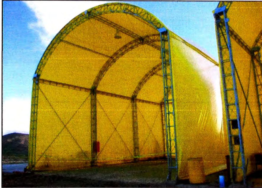
Figura 3.3 – Taller de mantenimiento portátil, fácil de instalar y de fácil acceso.
