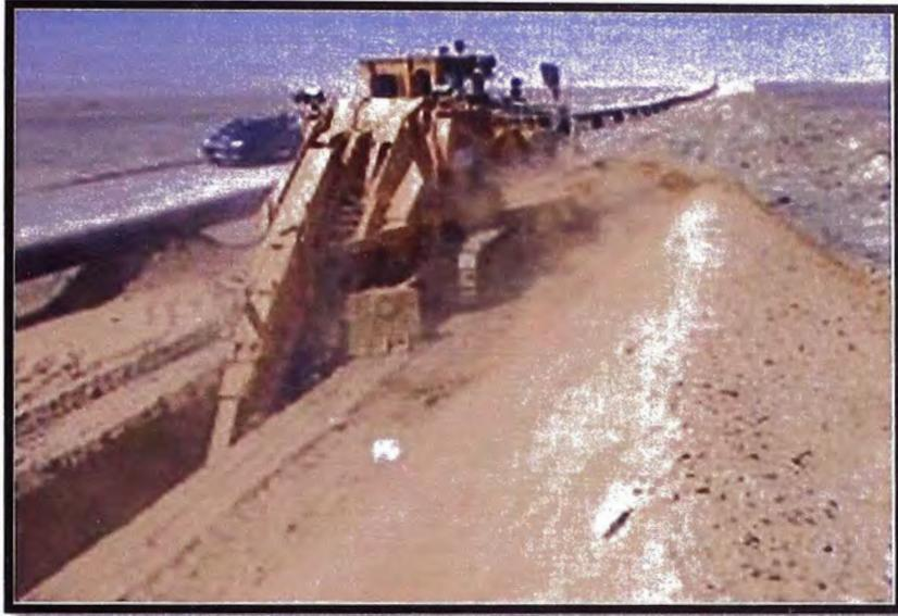
**Figura N°24: Excavación de zanja con zanjadora Trencor 1260**
