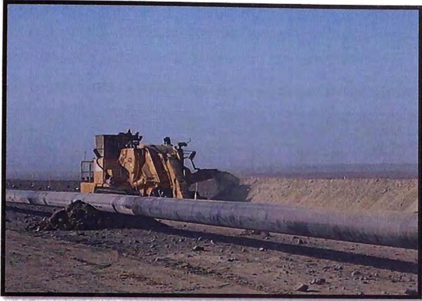
Figura N°27: Tubería a instalar en zanja excavada por equipo Trencor 1260.
