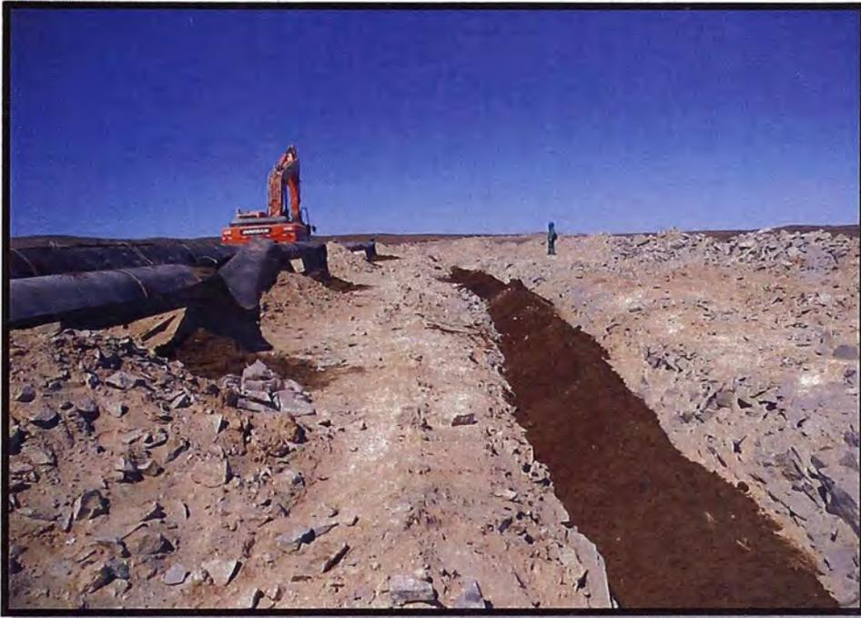
Figura N°10: Protección de zanja con arena húmeda y con mantas de HDPE sobre la tubería.
