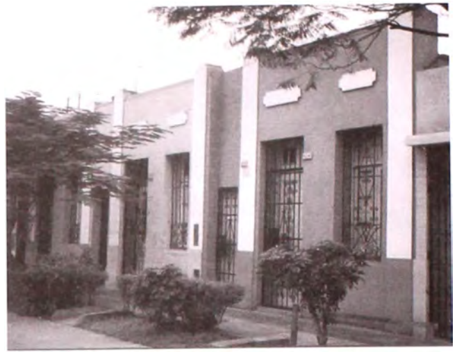
1. Viviendas con decoración de formas geométricas Santa Beatriz. Foto 2002
