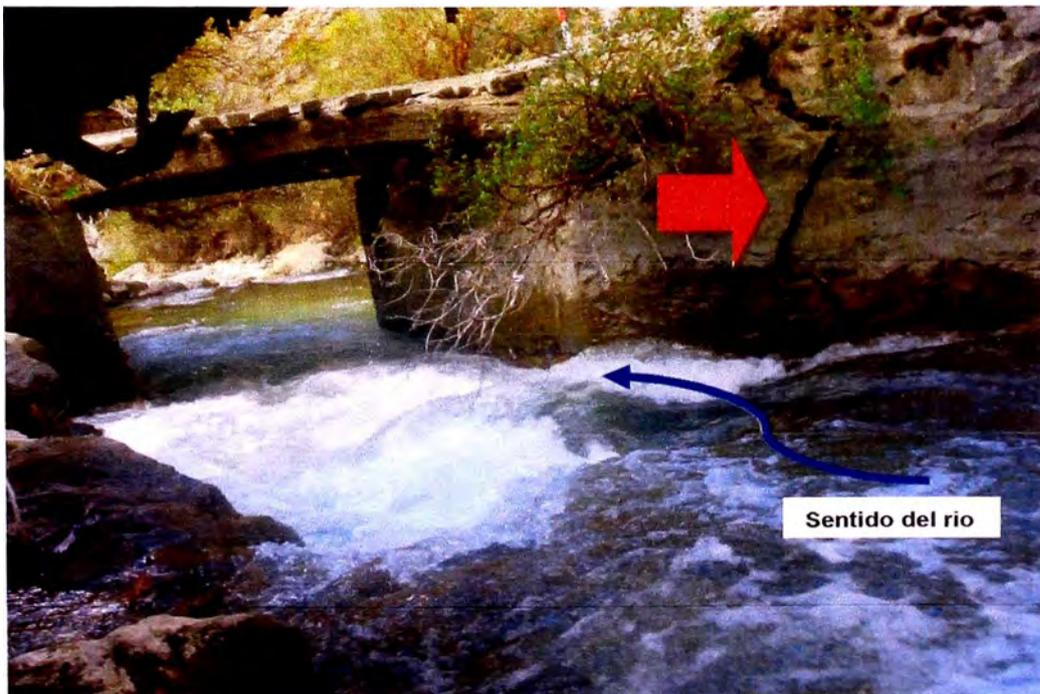
Fig. 8: Observamos que el ala del estribo derecho de norte a sur se encuentra con una fisura, debido a la erosión del río, que constantemente choca con el ala del estribo.
