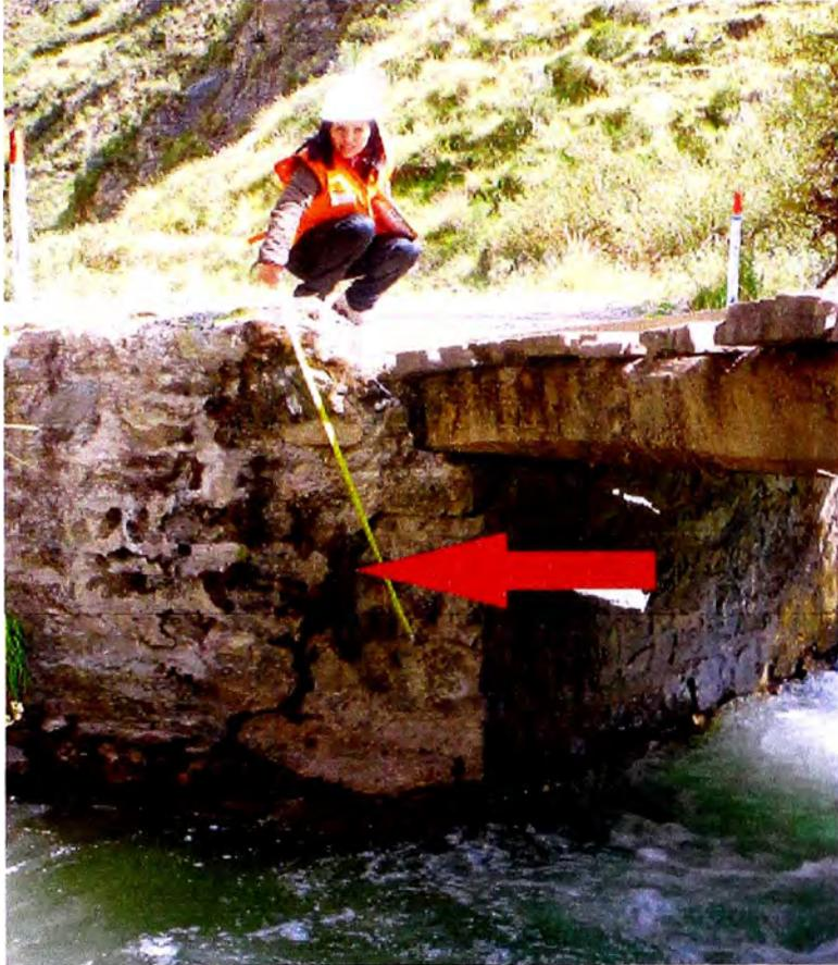
Fig. 7: Observamos que el ala del estribo izquierdo de norte a sur se encuentra con una fisura, debido al asentamiento del suelo en los accesos al puente.
