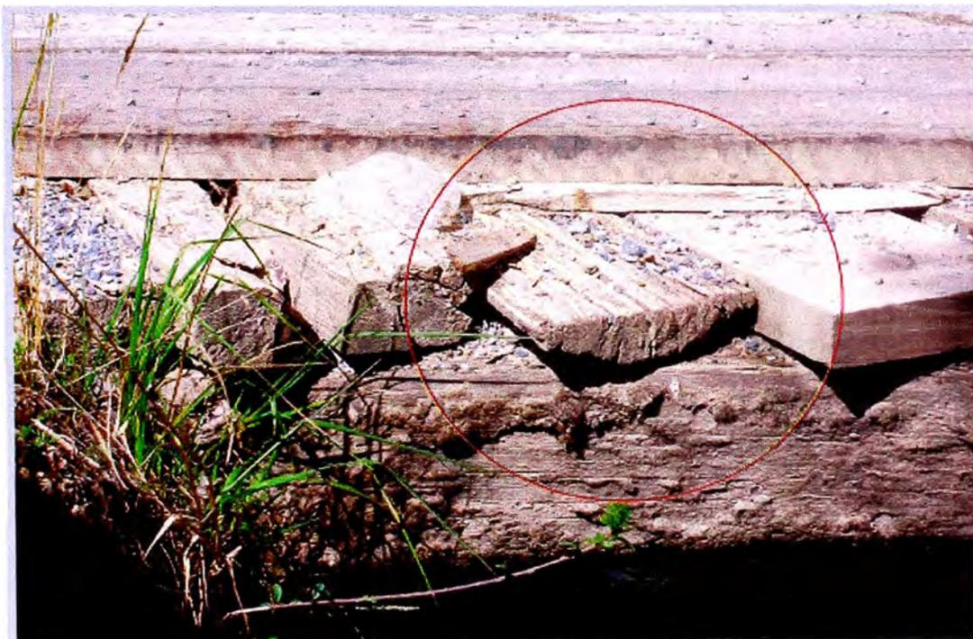
Fig. 6. El tablero de la estructura se encuentra en proceso de descomposición y requiere de tratamientos a la madera para su conservación.
