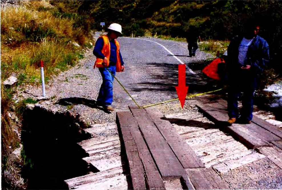
Fig. 1: Se muestra el deterioro del tablero debido a la falta de mantenimiento.
