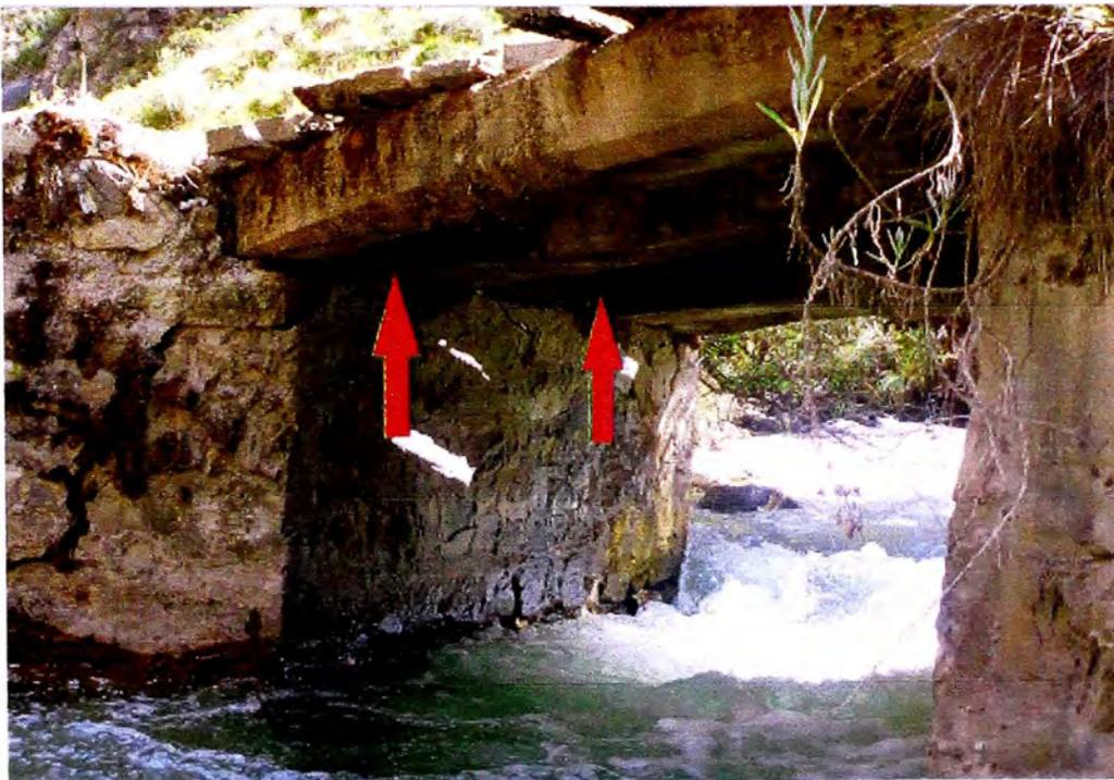
Fig. 2: Se observa la falta de elemento de apoyo para la viga, ya que esta actúa directamente con el estribo.
