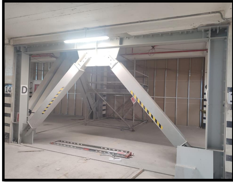
Figura 15: Reforzamiento de sótanos – Centro comercial Plaza del Sol Fuente: Propia. (2022).
