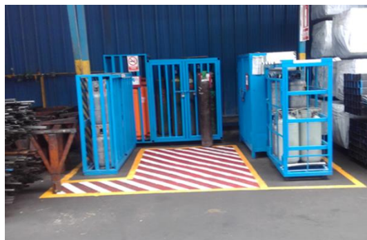
Identificación de almacén de balones de gas
