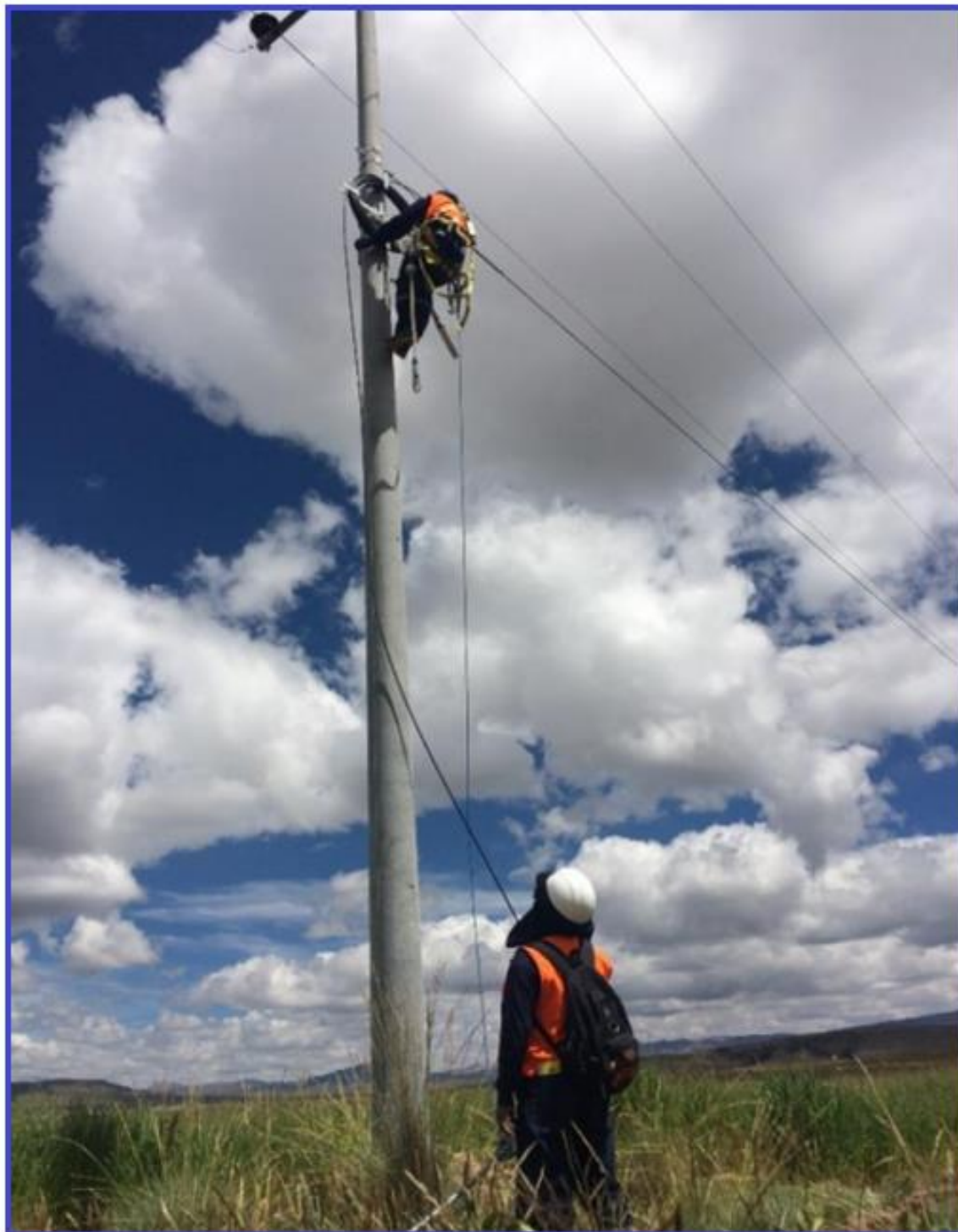
Fig. 3.7: Trabajo e inspección en tendido de fibra óptica.
