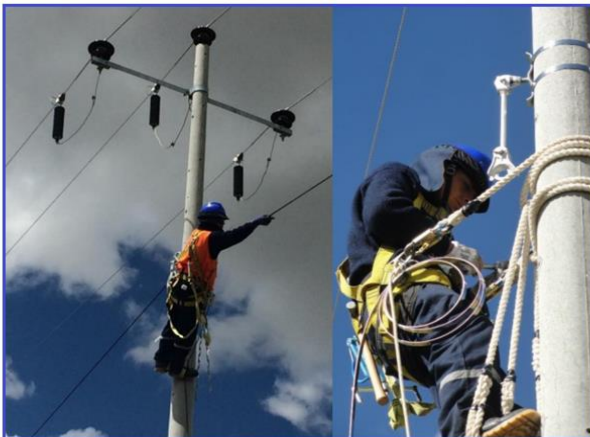
Fig. 3.4: Tendido de F.O. preformados y amortiguadores.
