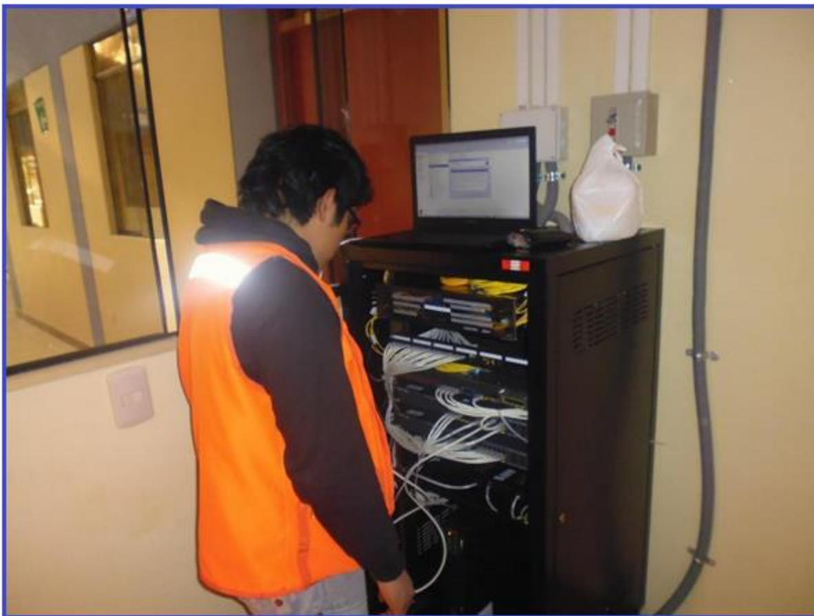
Fig. 4.6: Trabajos de configuración de equipos de comunicación
