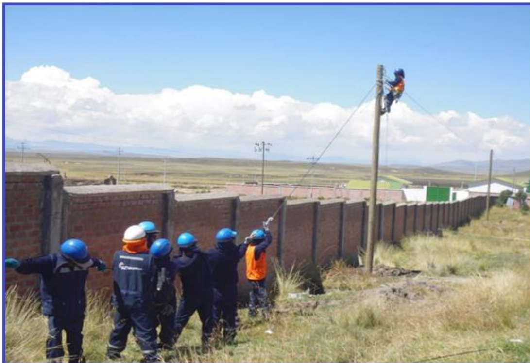
Fig. 3.8: Flechado de fibra óptica.
